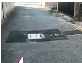
道路が落ち込んだ 下水道改修
